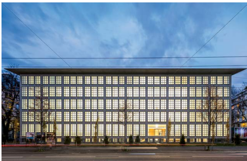
Original mit einer einzigen Änderung: Südwestfassade der instandgesetzten Zentral- und Hochschulbibliothek Luzern
